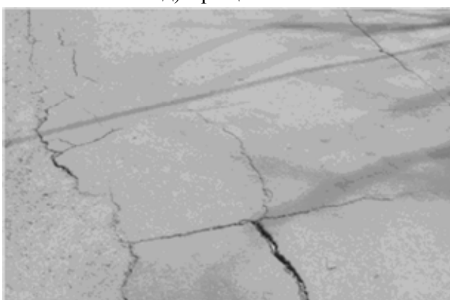
д) Трещины
